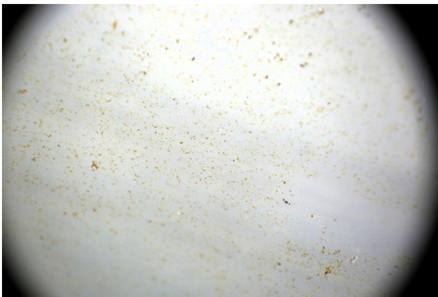
Figur 6: Foto från Micans som visar spår av rost på insidan av röret från kontrollsidan, men ingen biofilm syns.
